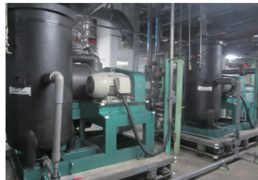
PV 系統效能提升 -Overall 作業提升運轉效率
