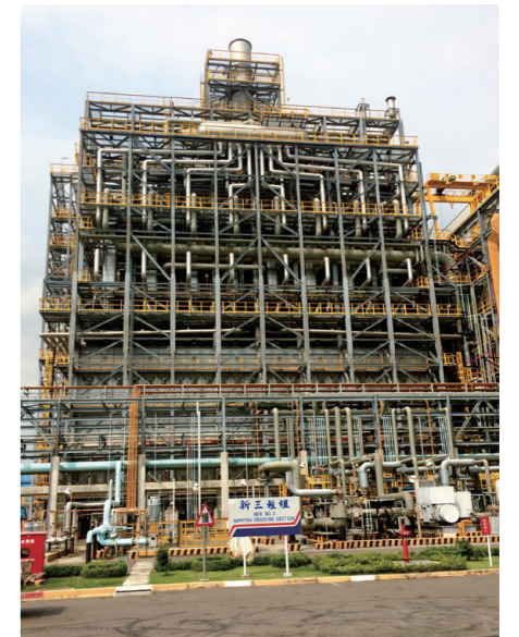
中油林園石化廠三輕更新 (裂解爐)
