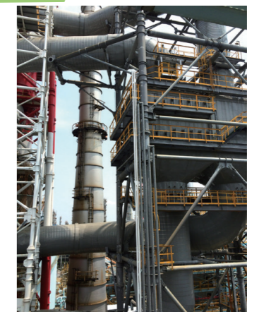
石化廠廢熱回收 (熱管換熱器)
