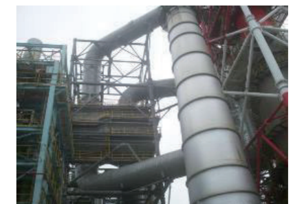
石化廠廢熱回收 (熱管換熱器)
