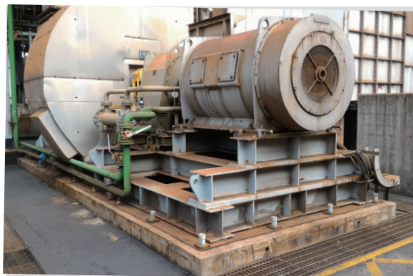
煉焦推焦集塵系統更換為高效節能型風車
