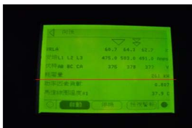
當冰水出水溫度設定在8.0°C時，主機負載耗電量降為261kW
