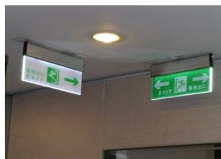
← 舊式避難方向指示燈更換為LED面板指示燈
