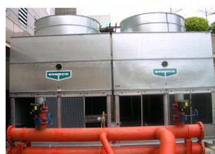
← 5號空調主機新增 設在6F之冷卻水塔
