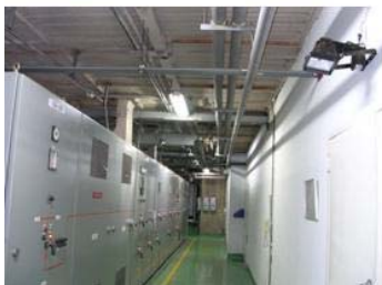
← 機房內設置 自動點滅器
