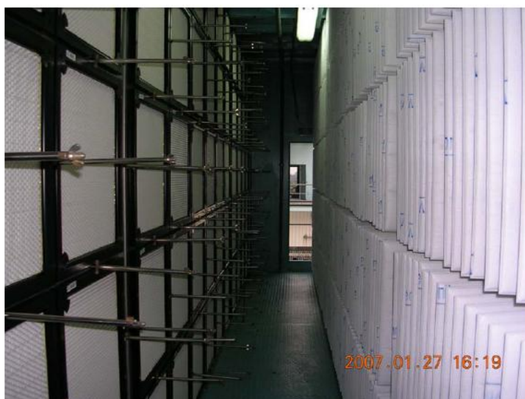
圖三、新型空氣進氣濾網及 pre-filter 牆施工完成後照片
