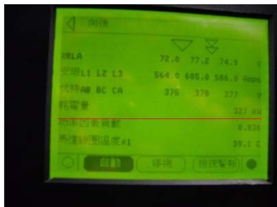
當冰水出水溫度設定在7.0°C時，主機負載耗電量為327kW
