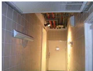
← 機房內設置 自動點滅器
