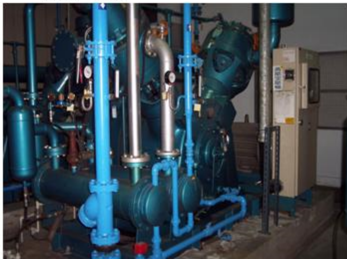
40bar 高壓空壓機
