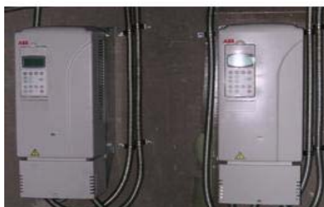
冷卻水塔風車 更換後控制盤 及變頻器
