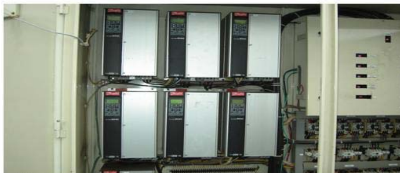
一般冰水主機冷卻水塔現場變頻器×6台
