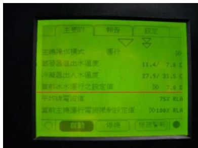
冰水主機冰水出水溫度設定在7.0°C
