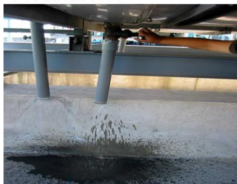
冷卻水塔底部排水(污水)
