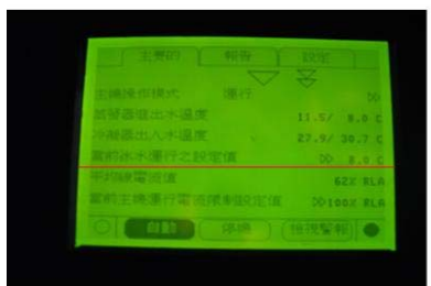
冰水主機冰水出水溫度設定在8.0°C
