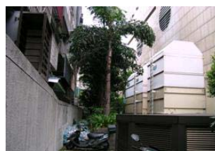
← 5號空調主機設置在 1F鄰房旁之冷卻水塔
