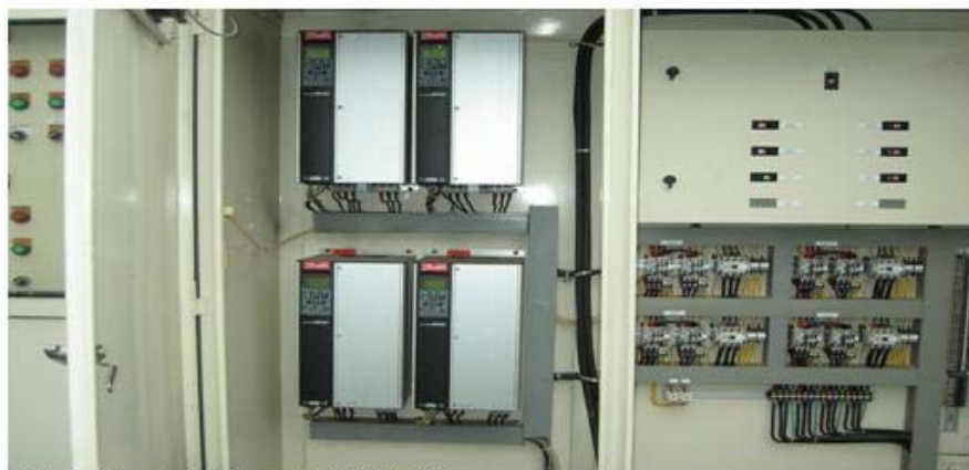
儲冰用冰水主機冷卻水塔現場變頻器×4台
