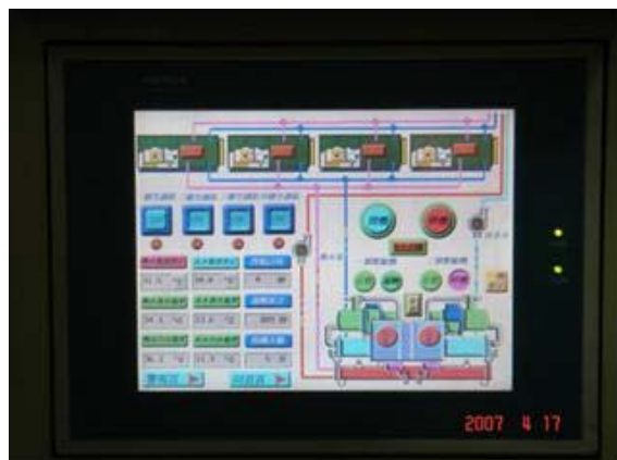
〔游泳池水對水熱泵主控盤〕
