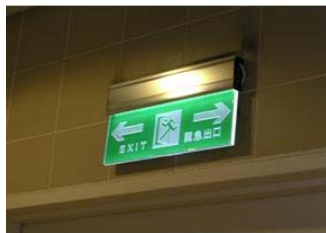
← 舊式安全門指示燈更換為LED面板指示燈
