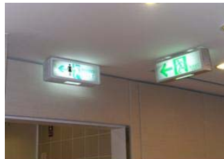
← 消防標示設備舊式避難方向指示燈
