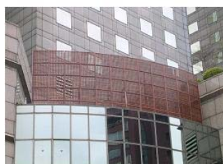
← 6F新增設冷卻水 塔之隔柵欄外觀
