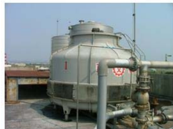
沼氣發電機冷卻水塔
