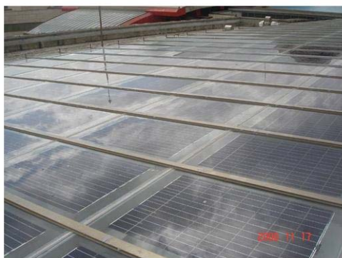
改善後頂樓透明玻璃帷幕以太陽光電板鋪陳吸熱
