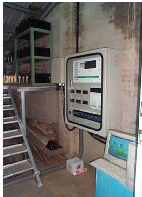
〔太陽光電系統控制系統〕
