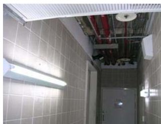
← 機房走道設置 自動點滅器
