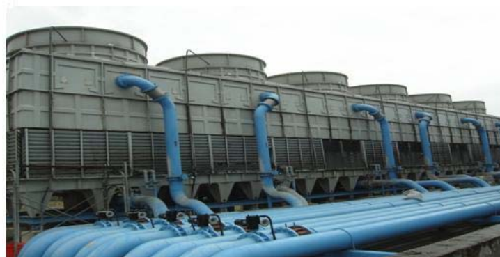
一般冰水主機冷卻水塔現場實景×6台
