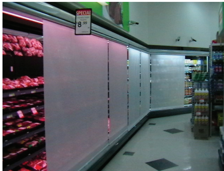
圖 8-6 開放式展示櫃加置夜間節電夜簾及溫控
