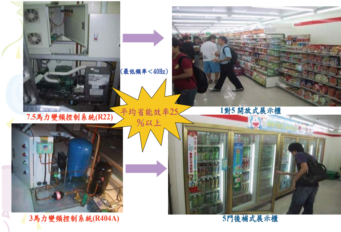
圖 8-2 展示櫃採用變頻控制系統
