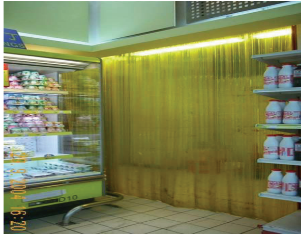
圖 8-8 冷凍冷藏食品區域倉庫門雙廉 PVC 門簾
