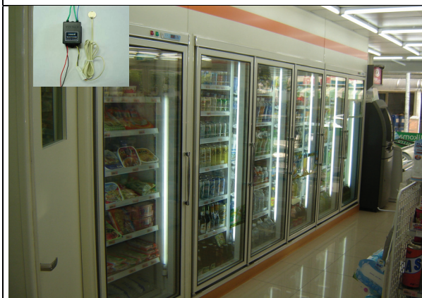
多門飲料冷藏櫃玻璃門裝置 除霧濕度感應控制器
