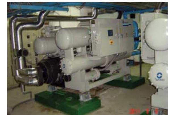
單身宿舍冰水主機汰換
