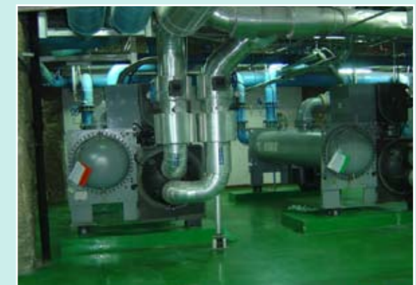
醫療及門診大樓冰水主機汰換
