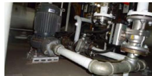
冷凍機冷凝器自動清洗裝置
