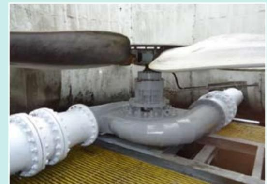
冷卻水塔風車改為水渦輪式
