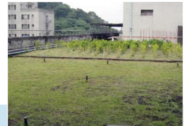
教學大樓頂樓隔熱裝置
