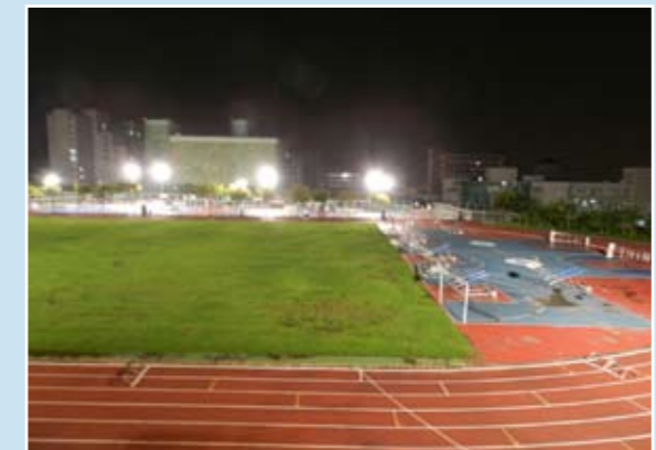
操場複金屬投射燈汰為陶瓷複金屬投射燈
