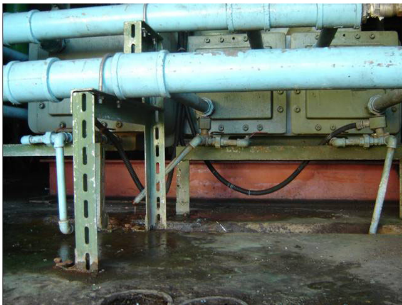
圖14 排水器安裝前
