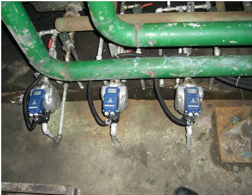
圖17 排水器安裝後
