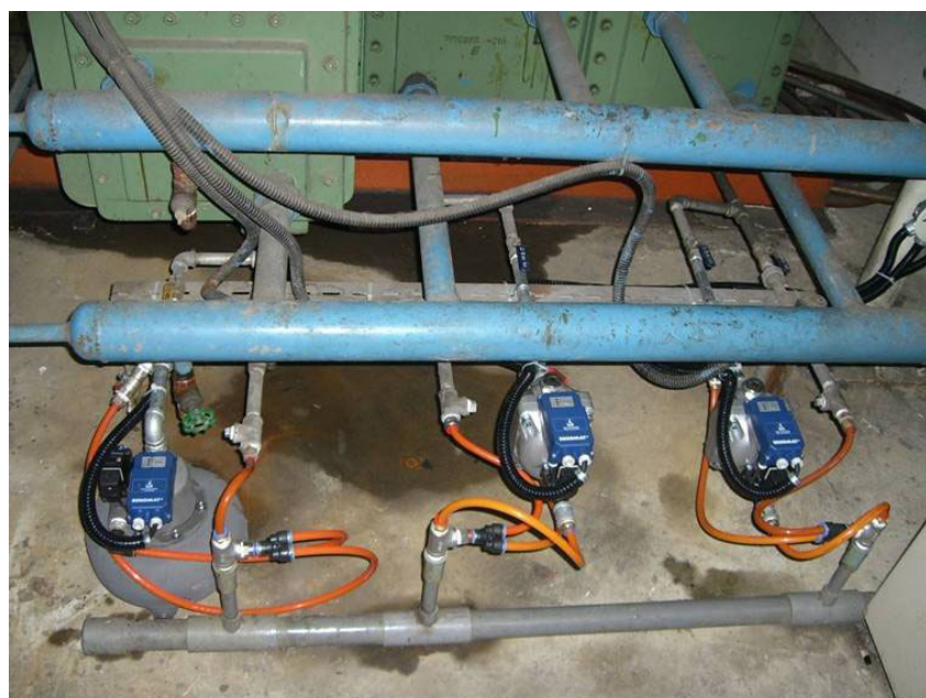
圖19 排水器安裝後
