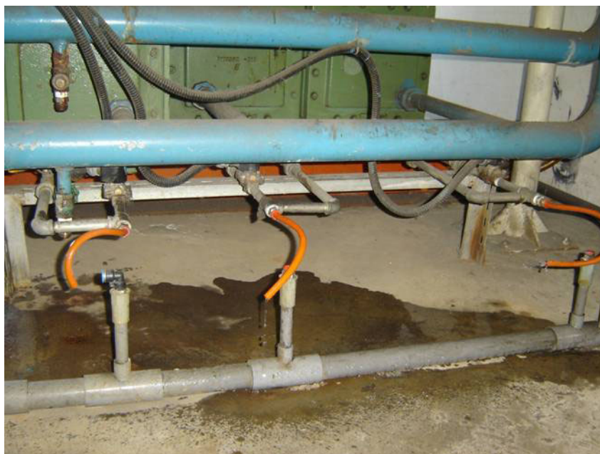
圖18 排水器安裝前
