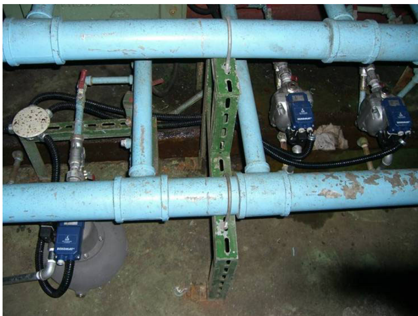
圖15 排水器安裝後
