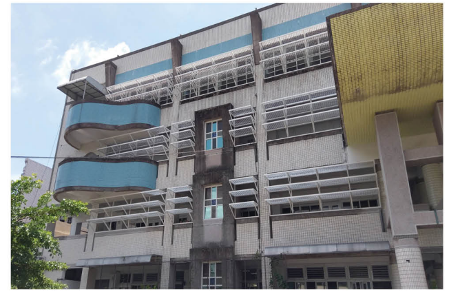
西曬教室裝設外遮陽設施
